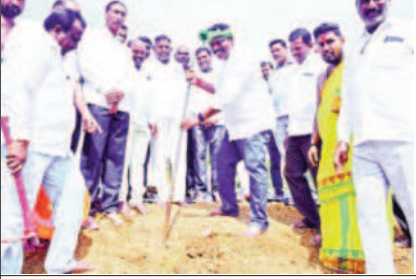
మోతే రిజర్వాయర్ కాలువ నిర్మాణ పనులు
